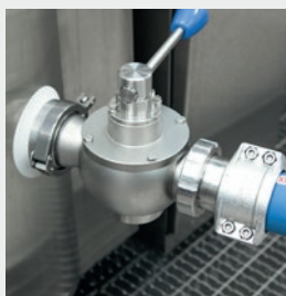
Kaariventtiili CIP D2 51DS52(0)M43/21466 TC63/D urosliitin
