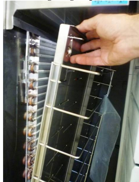
Avlägsning av plåten
